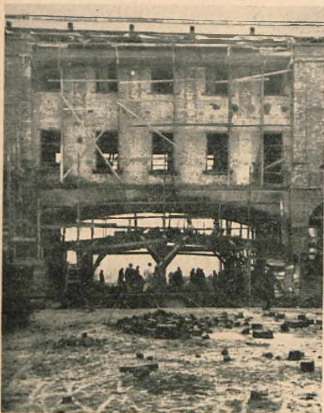
Rys. 3. Widok otworu z rusztowaniami do tynków.
