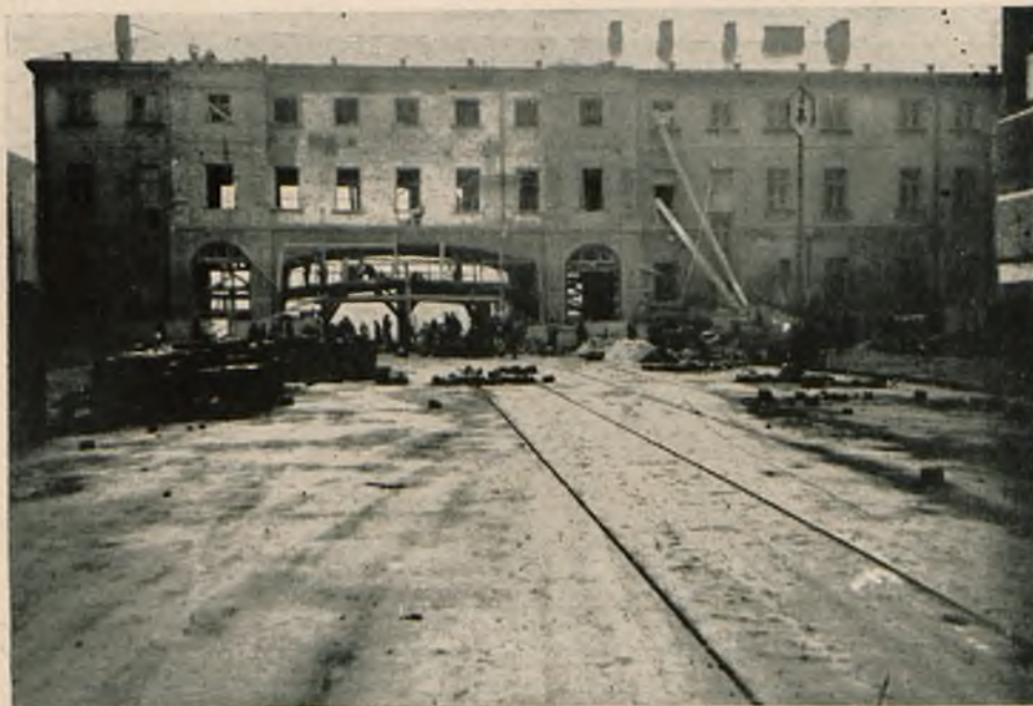
Rys. 2. Widok gmachu w czasie przebudowy od ul. Św. Jerskiej.
