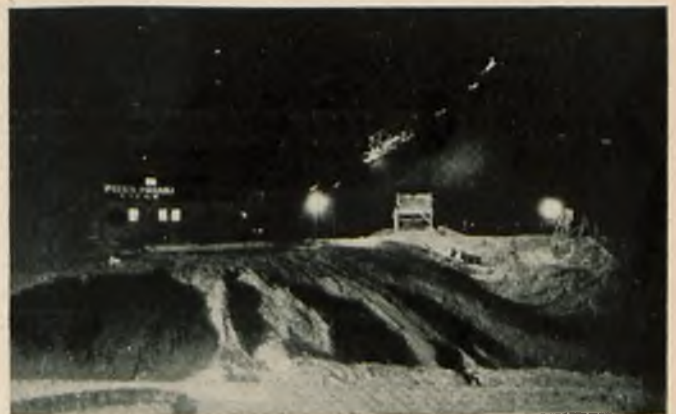
Rys. 1. Plac budowlany, oświetlony lampami sodowymi.
