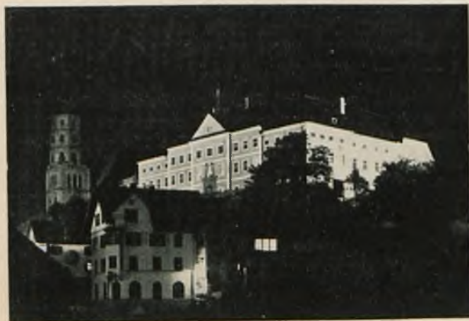
Rys. 2. Zamek oświetlony lampami sodowymi.
