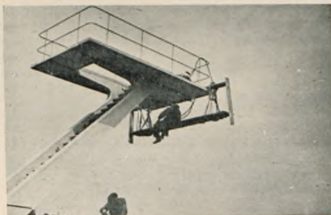
Fot. 14. Montaż rur wodotryskowych na przedniej krawędzi podestu znajdującego się na poziomie + 10,00 m.
