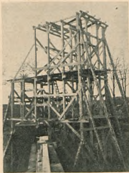
Fot. 3. Górna część rusztowania do budowy wieży.
