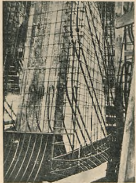
Fot. 7. Zbrojenie żeber fundamentu wieży.
