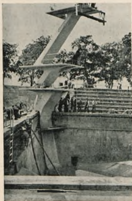
Fot. 12. Widok całości konstrukcji od strony plaży.
