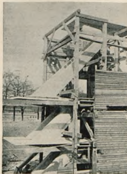
Fot. 10. Rozszalowana konstrukcja spoczywa jeszcze na rusztowaniu. Widoczny — w tylnej części rozebrany — cieplak.
