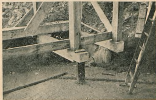
Fot. 4. Oparcie tylnych słupów rusztowania na słupkach odcinków dwuteownika.
