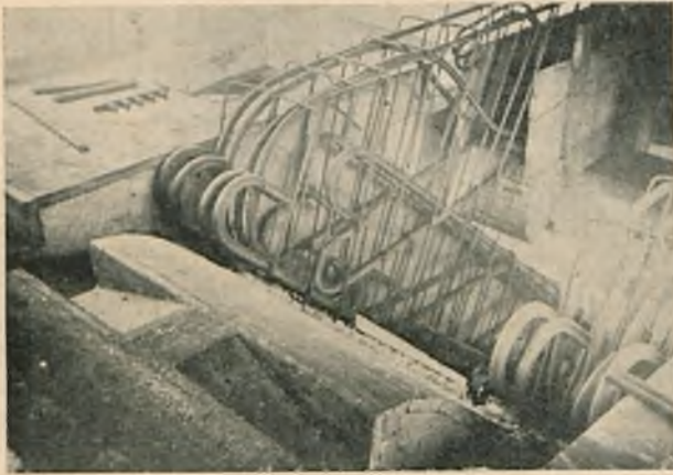
Fot. 6. Zbrojenie węzła na podeście + 3.00 (niekompletne i jeszcze nie powiązane). Na hakach łatwe do zaobserwowania gięcie stali w płaszczyźnie dłuższej osi przekroju. Na podszalowaniu (przyprószonym śniegiem) obok skrzynki do gwoździ — przytrzymywacz-grzebień z przyspawanymi zębami.
