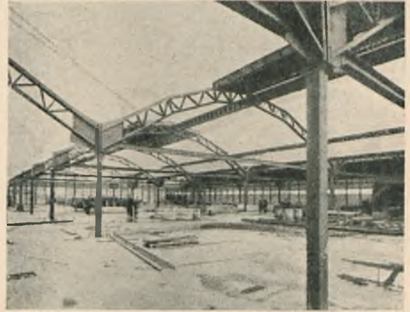
Rys. 4. Widok hali warsztatowej w czasie montażu. Zwraca uwagę lekkość słupów.
