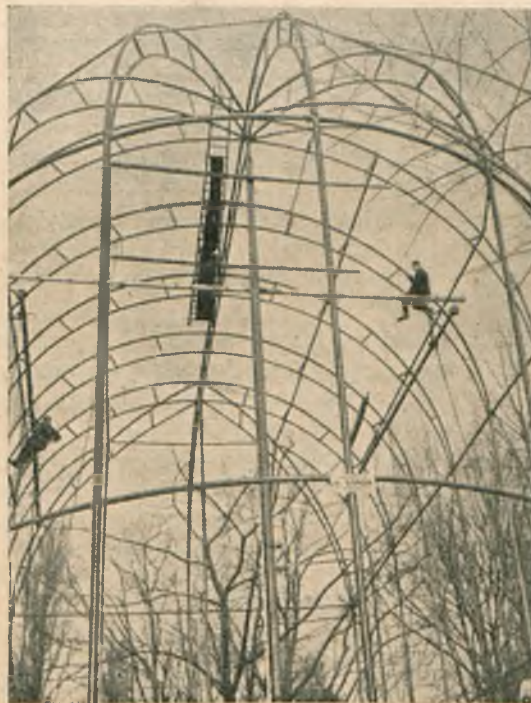
Szczegół konstrukcji ptasznika podczas montażu.
