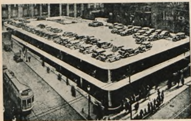
Rys. 29. Widok garażu postojowego w Pittsburgu (Architectural Record).
