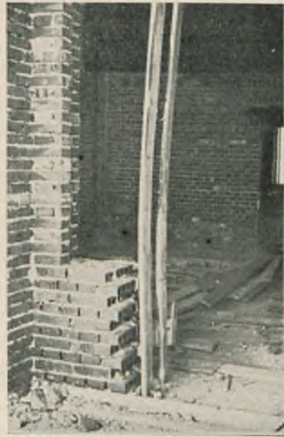
Rys. 28. Stemple z jednocalowych desek.
