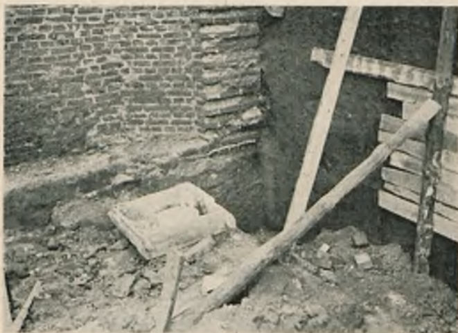
Rys. 24. Podparcie od niechcenia pionowej ściany wykopu.
