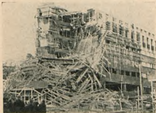
Rys. 30. Zawalenie się 6-cio piętrowego domu w Oslo w r. 1937 z powodu nie związania cementu w czasie mrozu.
