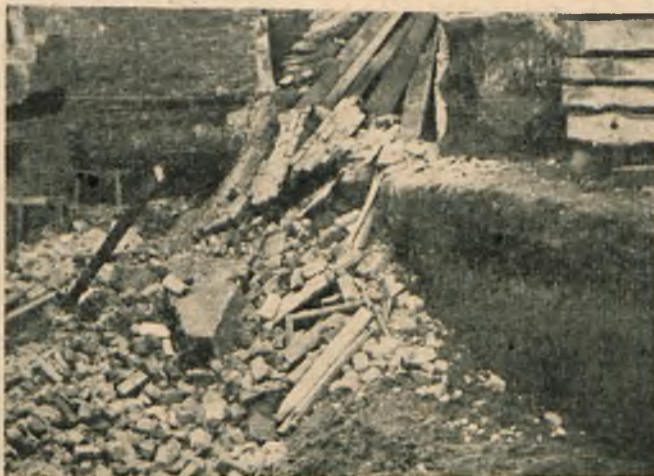
Fot. 3. Rumowiska ścian i stropów, oraz w większej skali „prawidłowo” pionowe skarpy wykopu tuż przy resztkach ścian.
