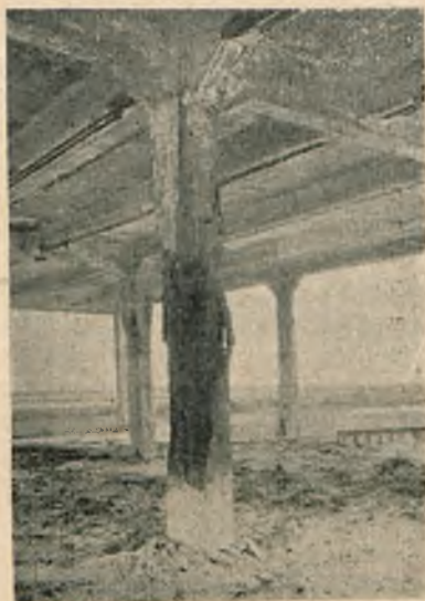
Rys. 16. Słup żelbetowy po pożarze w Rydze: widuć wykruszoną warstwę zewnętrzną betonu i odsłonięte uzbrojenie.
