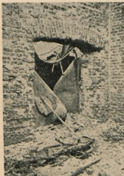
Rys. 16. Słup żelbetowy po pożarze w Rydze: widuć wykruszoną warstwę zewnętrzną betonu i odsłonięte uzbrojenie.
