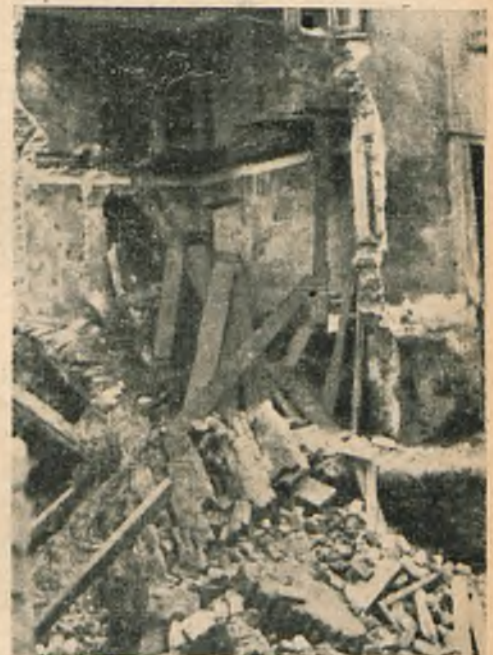
Fot. 2. Część dolna widoku ogólnego. Widoczna z prawej strony pionowa skarpa wykopu.
