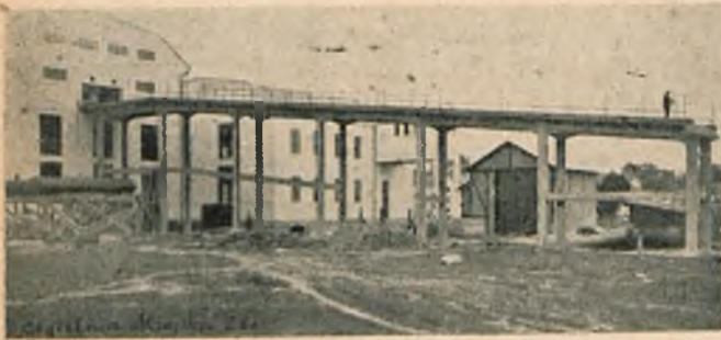
Rys. 12. Widok budynku z pochylnią. Wiatr odbijając się od pochylni spowodował dzięki otwartym wrotom znaczne ciśnienie we wnętrzu, które spowodowało zerwanie dachu.
