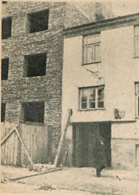
Fotografia wskazuje, iż nieraz zapomina się o tym, że budując obok istniejącego budynku, — należy zwracać baczną uwagę, aby nowa bu-
