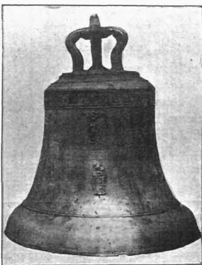
Naprawiony dzwon z Ruszczy pod Krakowem. Pęknięcie pionowe od krawędzi dolnej dochodziło do kolan płaskorzeźbionej M. Boskiej.
