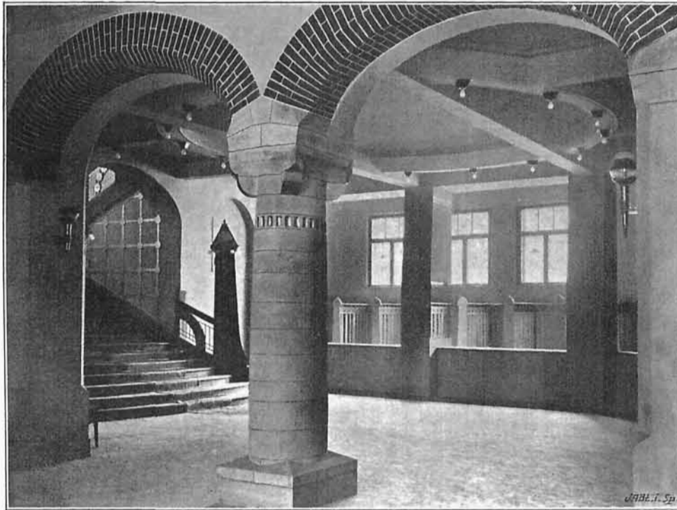
Ryc. 16. Westybul, szatnie i schody główne.
