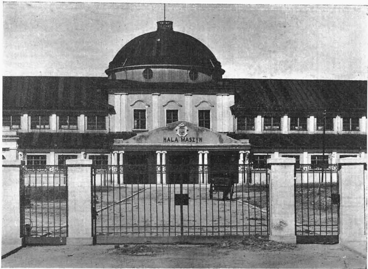
MIEJSKI WYDZIAŁ BUDOWLANY W POZNANIU, pod kier. ARCH. KAZIMIERZA RUCIŃSKIEGO. HALA MASZYN NA TARGACH POZNAŃSKICH. Fragment centralny z głównym wejściem.
