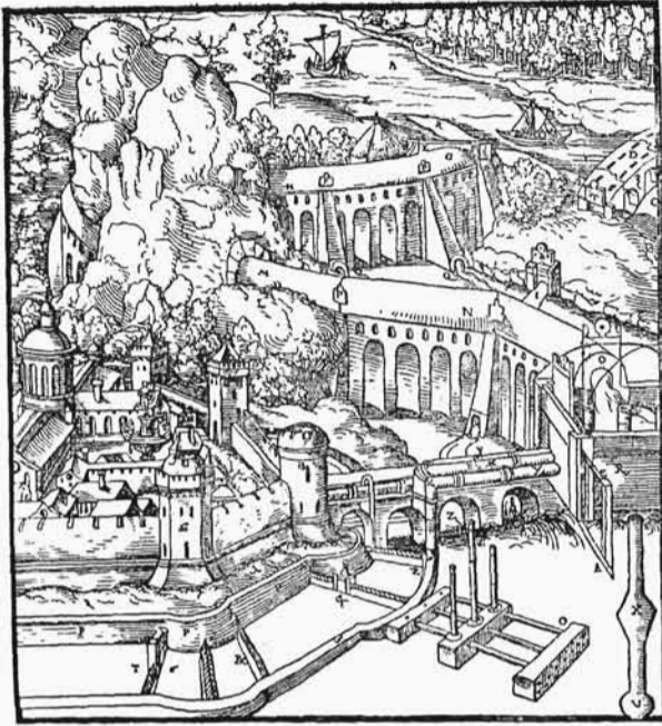
BUDOWA WODOCIĄGU. DRZEWORYT.
