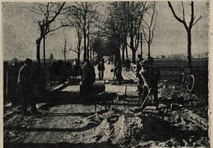
Układanie ralki i warstwy wyrównawczej piasku.
