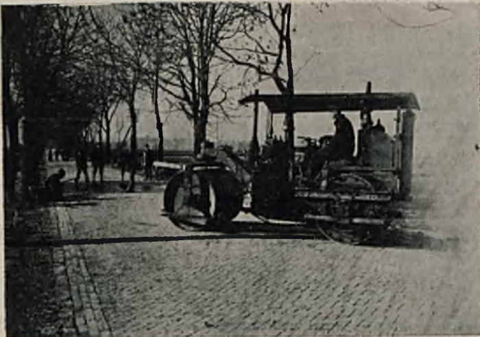
Wałowanie i zalcwanie spoin.
