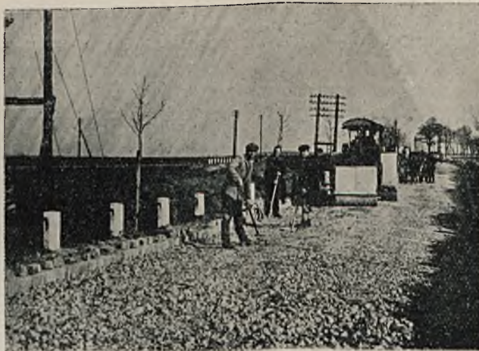
Renowacja podłoża. Rozsypywanie szabru i walcowanie ciężkim wálkiem.
