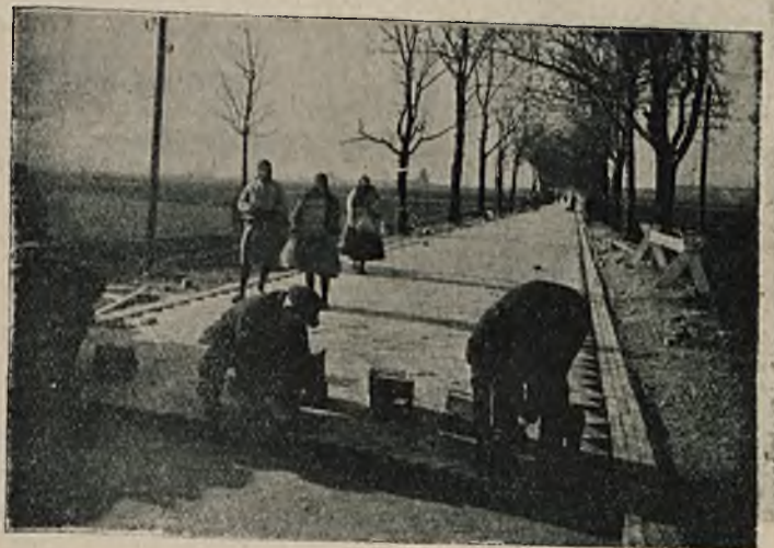
Układanie klinkieru.
