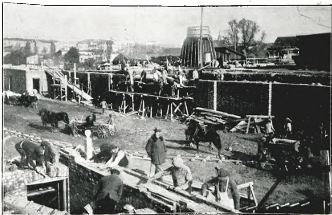
Fot. 6. Piotrków. Budowa Hali Targowej (fundamenta i podziemie) (str. 192).
