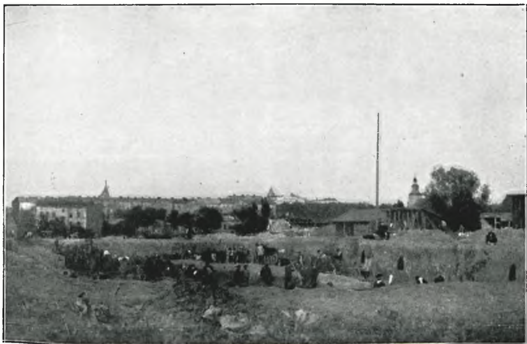
Fot. 5. Piotrków. Wykop pod fundamenta dla Hali Targowej (str. 192).
