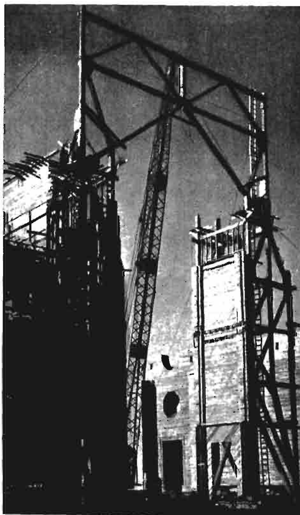
Rys. 3. Montowanie łuku o wysokości 31,40 m, przy pomocy żurawia.
