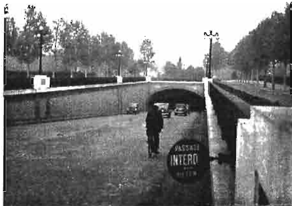
Rys. 3. Wjazd do tunelu pod Porte Dauphine.
