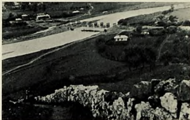
Fot. 9. Budowa mostu przez Bystrzycę na drodze powiatowej pod Wołoczynem.
