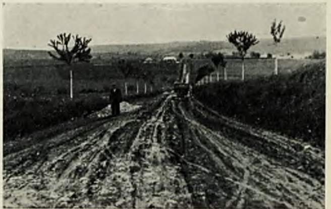
Fot. 5. Zniszczona wiosennymi przetłomami droga powiatowa Mykietyńce — Podłuże — Pobereże.
