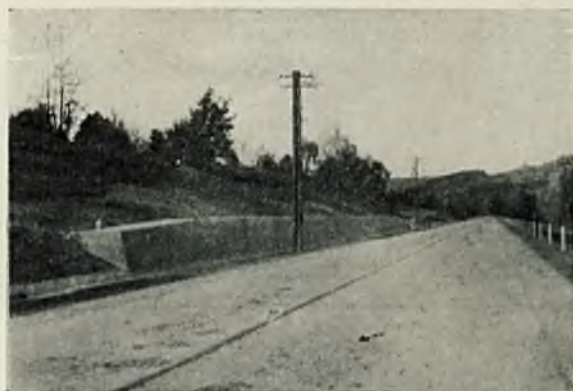
Droga z nawierzchnią betonową w km 340.
