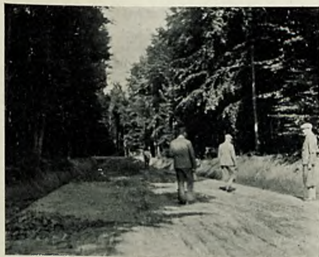
Fot. 8. Budowa nowej drogi gminnej.
