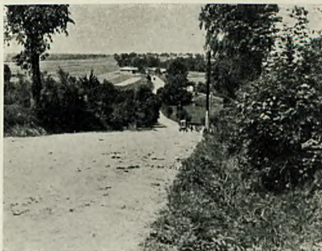
Fot. 6. Droga państwowa Nr 9/13, Stanisławów — Dolina. Na nawierzchni widać nawet na tej drodze dużą ilość „tłuźczy”.
