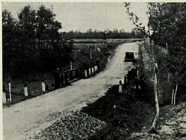
Fot. 7. Droga powiatowa Załukiew — Bednarów.
