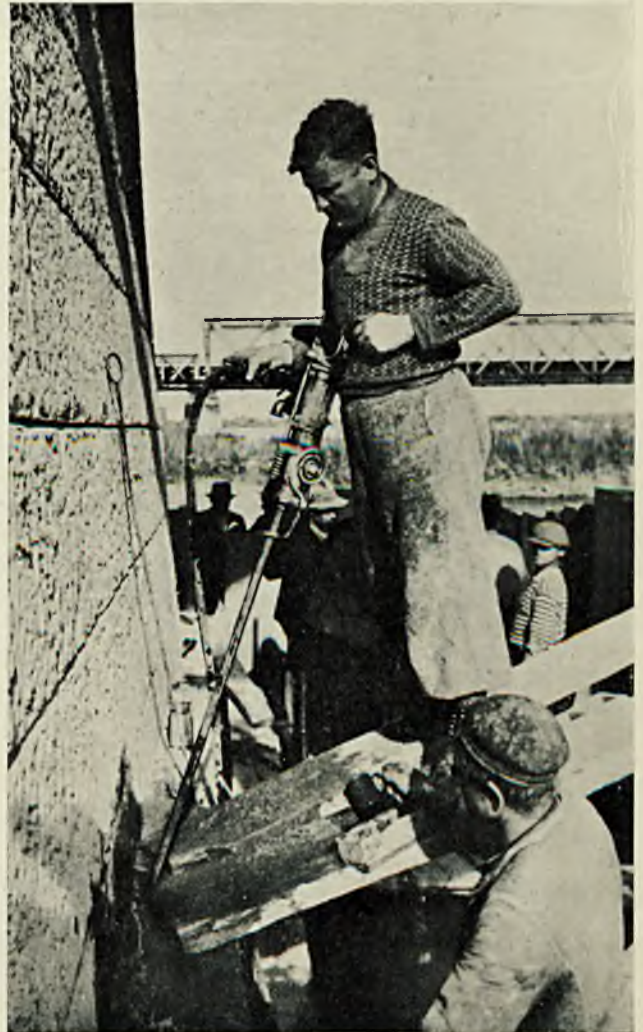
Fot. 3. Wiercenie z osadzki do fundamentu. W ten sam sposób wykonano wiercenia wstępne.
