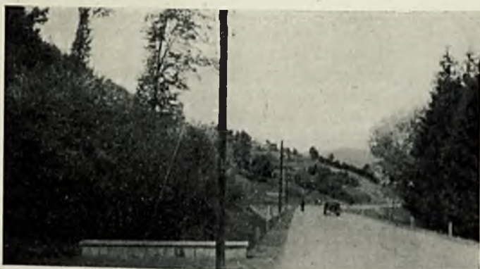
Piękny pod względem widokowym odcinek z nawierzchnią betonową w km 339
