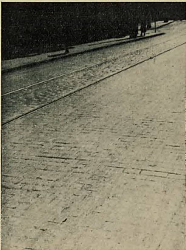
Rys. 2. Ul. Przechodnia w Warszawie po trzech latach jednego z najcięższych ruchów kołowych.
