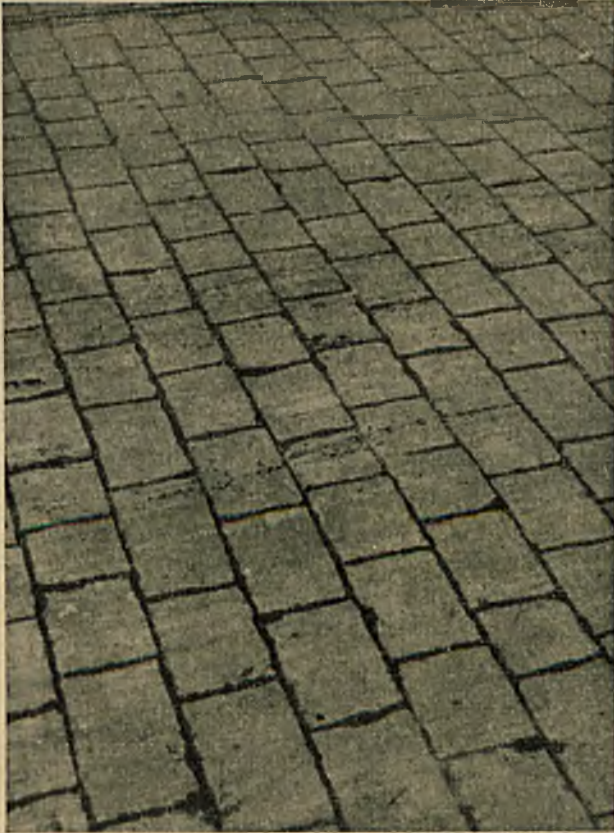
Rys. 1. Nawierzchnia zalewana zaprawą z cementu glinowego w Alei Jerozolimskiej po trzech latach b. ciężkiego ruchu.
