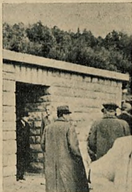
Rys. 2. Przejście dla pieszych pod autostradą (w budowie).
