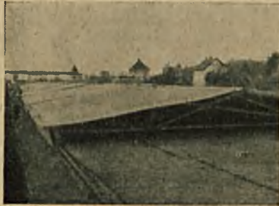
Rys. 12. Ochrona wykończonej nawierzchni.
