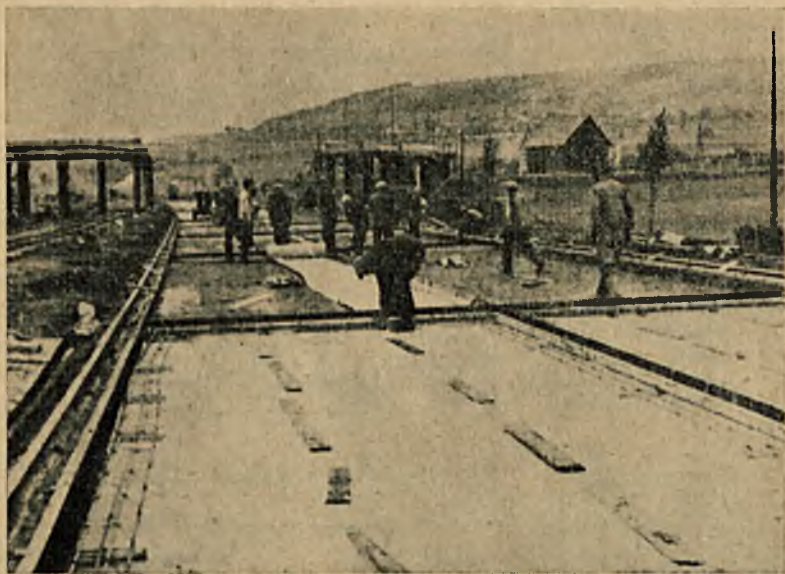
Rys. 6. Wstępne czynności przed naniesieniem betonu.
