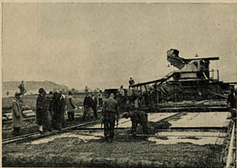
Rys. 8. Betoniarka na torze roboczym.
