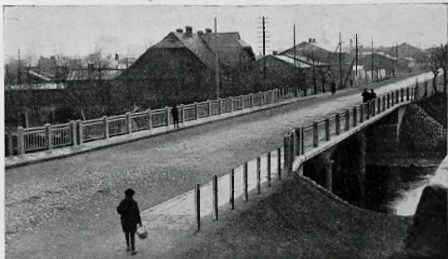
Rys. 13. Most na Ochni w Kutnie; rozpiętość 8.70 + 10 + 8.70 = 27.40 m. okres budowy 1930 r.
