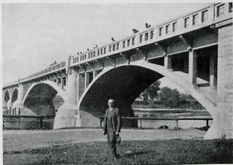
Rys. 5. Most na Sole w Oświęcimiu; rozpiętość 3 \times 23,25 + 42 + 23,25 = 135 m; okres budowy 1922—1924 r.
