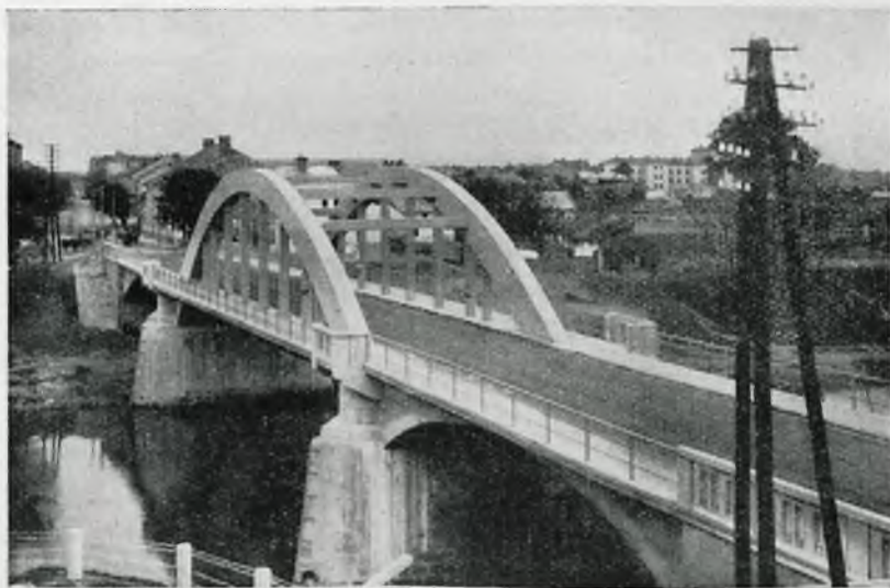
Rys. 1. Most na rzece Wisłoku w Rzeszowie; rozpiętość 20+38+20 = 78 m; okres budowy od 1925 r. do 1928 r.
