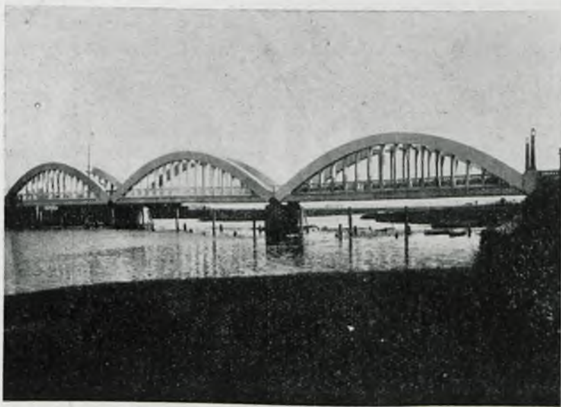
Rys. 2. Most na Bzurze w Łowiczu; rozpiętość 3 \times 31.12 = 93.36 m.; okres budowy 1927—1930 r.
