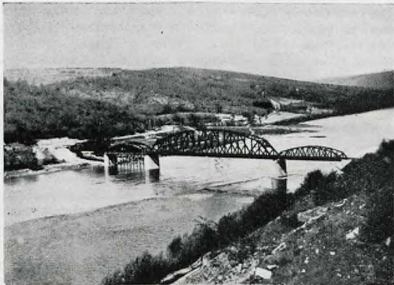
Rys. 7. Most na Dniestrze pod Uściczkiem; rozpiętość 40 + 100 + 40 + 40 = 220 m; okres budowy 1928—1930 r.
