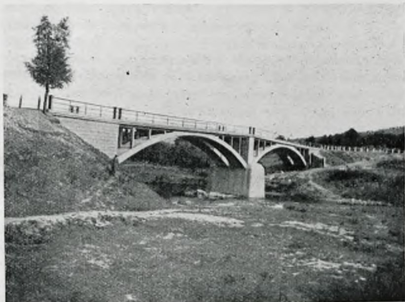
Rys. 6. Most na Wisłoku pod Żarnową; rozpiętość 35 + 35 = 70 m; okres budowy 1927—1930 r.
