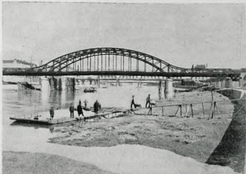
Rys. 10. Most na Wiśle w Krakowie; rozpiętość 34,8 + 34,68 + 34,81 = 138,42 m; okres budowy 1926—1931 r.
