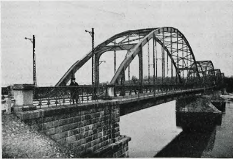
Rys. 12. Most na Bugu w Zegrzu; rozpiętość 4 + 77.65 = 310.60 m.; okres budowy 1928 — 1931 r.
