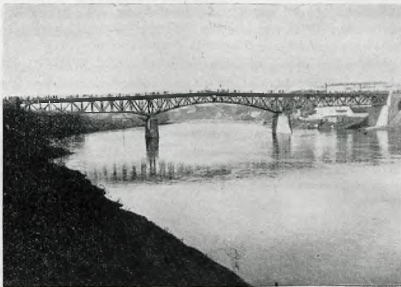
Rys. 8. Most na Niemnie w Grodnie; rozpiętość 52 + 60 + 52 = 164 m; okres budowy 1928—1930 r.
