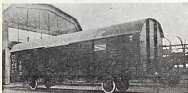
Wagony-meblarki, o pudle całkowicie spawanym, wykonywane przez Zakłady Ostrowieckie.
