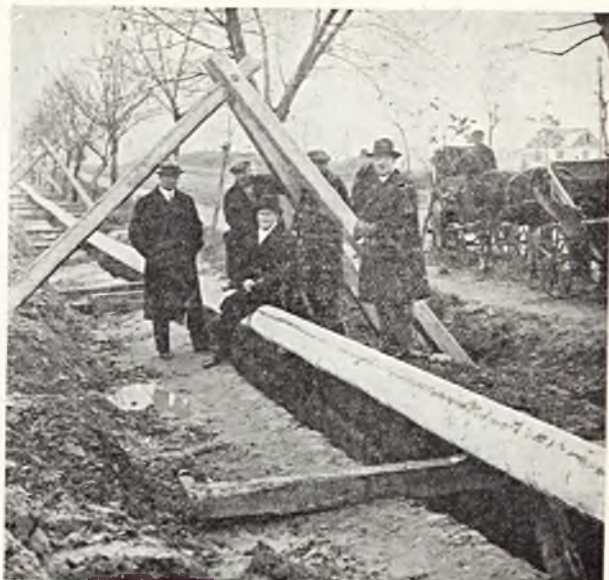
Spawany wodociąg w Łucku.
