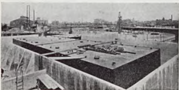
Rys. 6 i 7. Zbiorniki na benzynę o poj. 24000 m 3 wykonane za pomocą spawania (St. Zjedn.).
