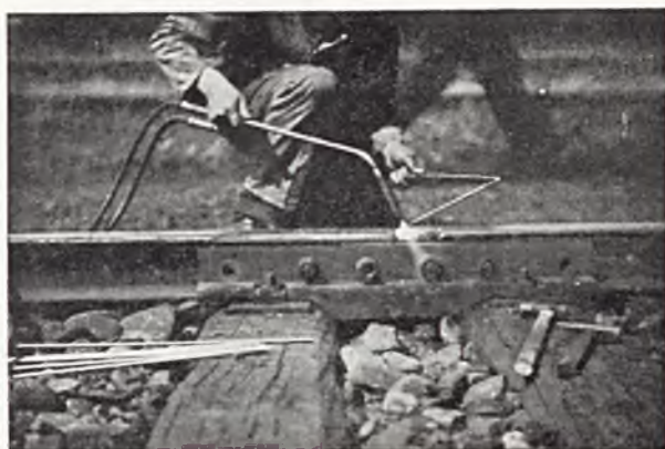
Napawanie końców szyn palnikiem acetylenowym.
