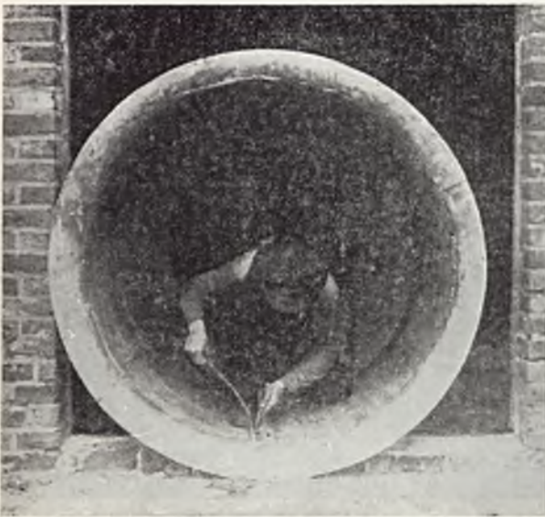
Nakładanie ołowiem zbiorników żelaznych.
