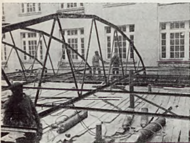
Dach Sali Kasowej P. K. O. w Warszawie.
