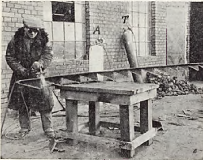
Wycinanie wsporników z teownika zapomocą tlenu.
