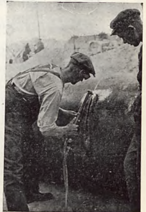
Rozbiórka mostu zapomocą palnika do'cięcia.
