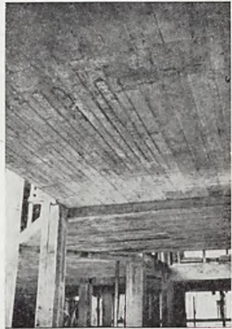
System ogrzewania krytego. Wężownice spawane po zabetonowaniu w stropie, przed nałożeniem wyprawy.
