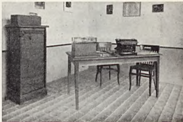
Rys. 3. Ogrzewanie elektryczne biura, umieszczone w posadzce.
