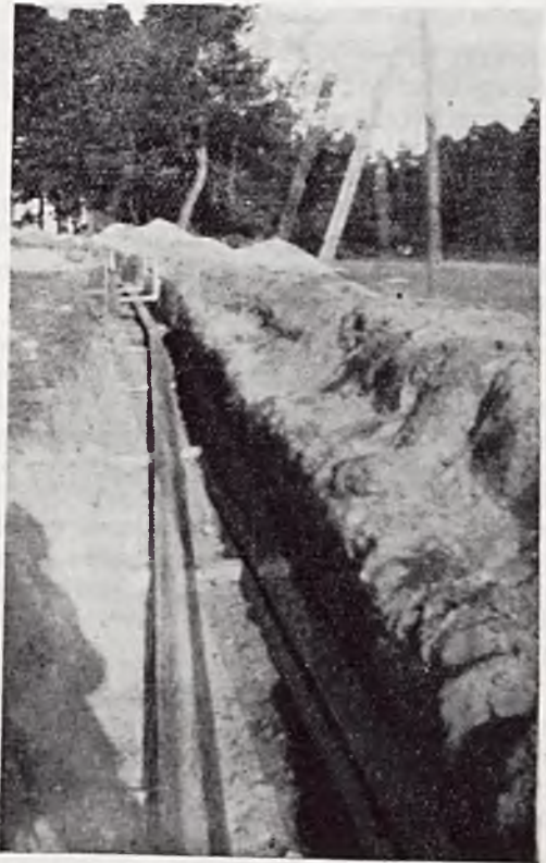
Rys. 5. Rurociąg gotowy opuszczony do wykopu. Ciemna linia obok — kabel elektryczny, ułożony jednocześnie w wykopie.
