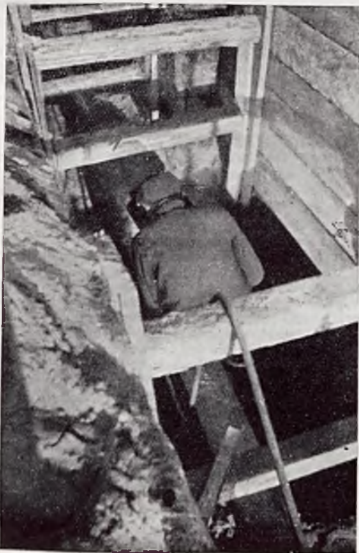
Rys. 4. Spawanie łukowe rur w wykopie.
