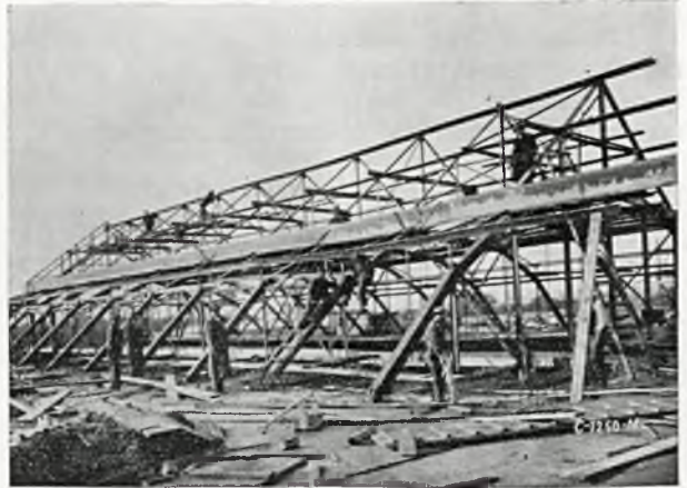
Rys. 7. Więzary dachowe w czasie montażu.
