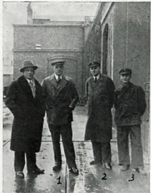
Rys. 5. Pan inż. Dziugiełł (1), obok p. majster Hanc (2) i operator p. Szczygieł.
