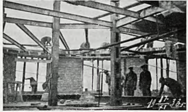
Rys. 3b. Układ belek w narożniku.
