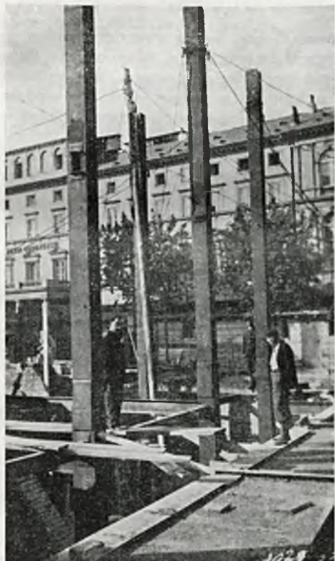
Rys. 10. Otwór w słupie dla podciągu ciągłego.
