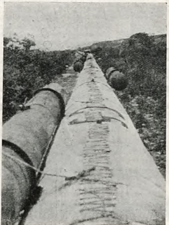
Rys. 164. Pływaki tymczasowe, do spuszczenia rurociągu na dno oceanu.
