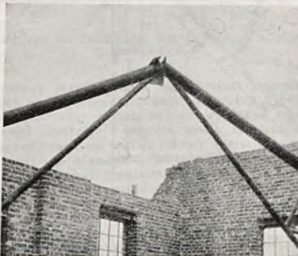
Rys. 12. Węzeł górny więzara przed spawaniem.
