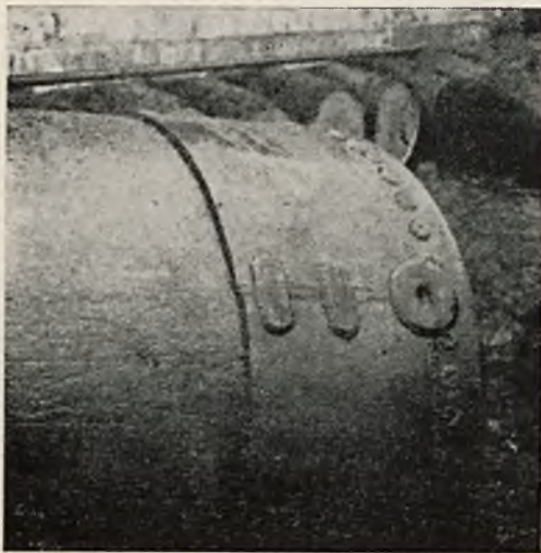
Rys. 1. Zbiornik parowy po naprawie.
