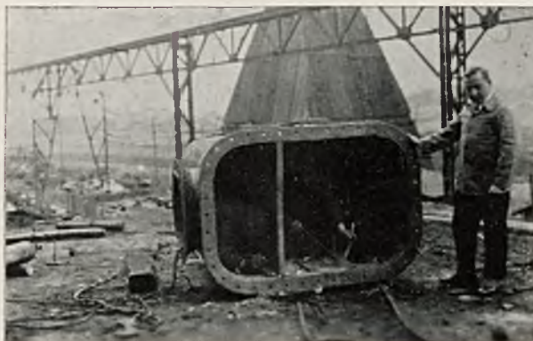
Rys. 3. Ołowienie po założeniu przegród.
