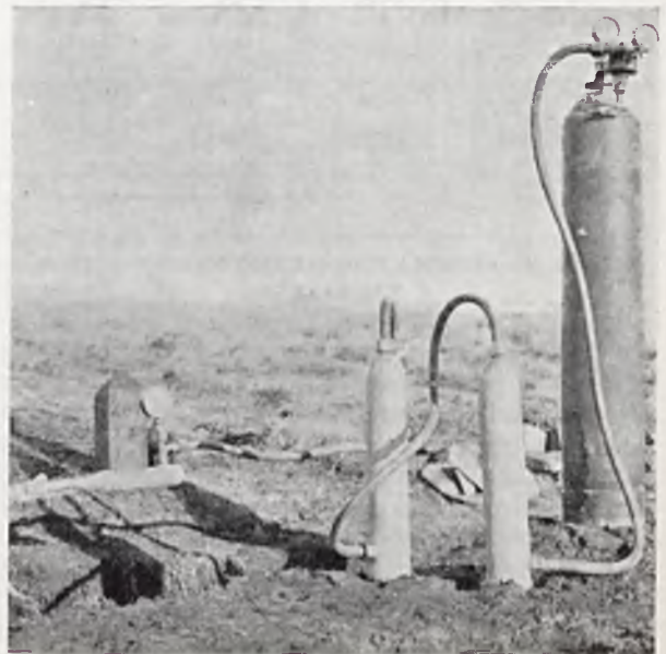
RYŚ. 1. KOMPLET APARATÓW DO ŁADOWANIA KABLA POWIETRZEM.
