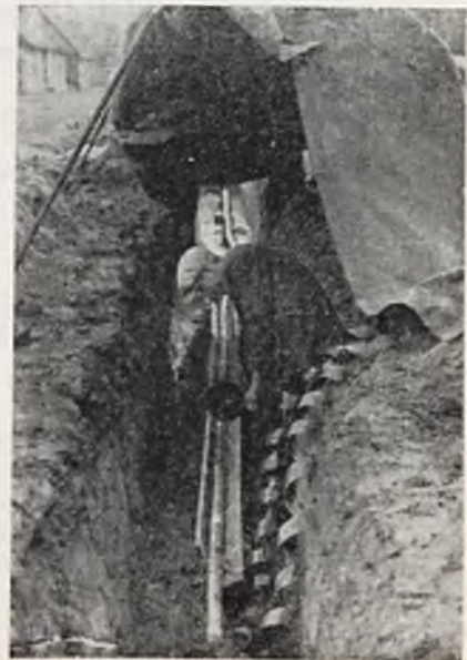
RYS. 10. OSUSZANIE KABLA.
