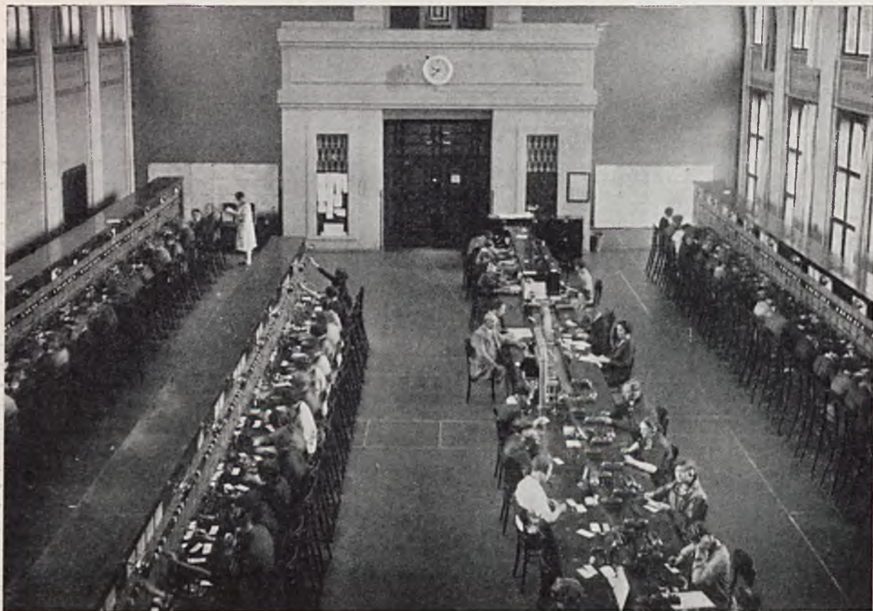
RYS. 2. MIĘDZYMIASTOWA CENTRALA TELEFONICZNA W PRADZE.
