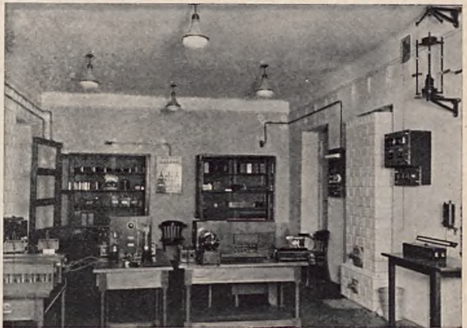
RYŚ. 6. SALA POMIARÓW TELETECHNICZNYCH.
