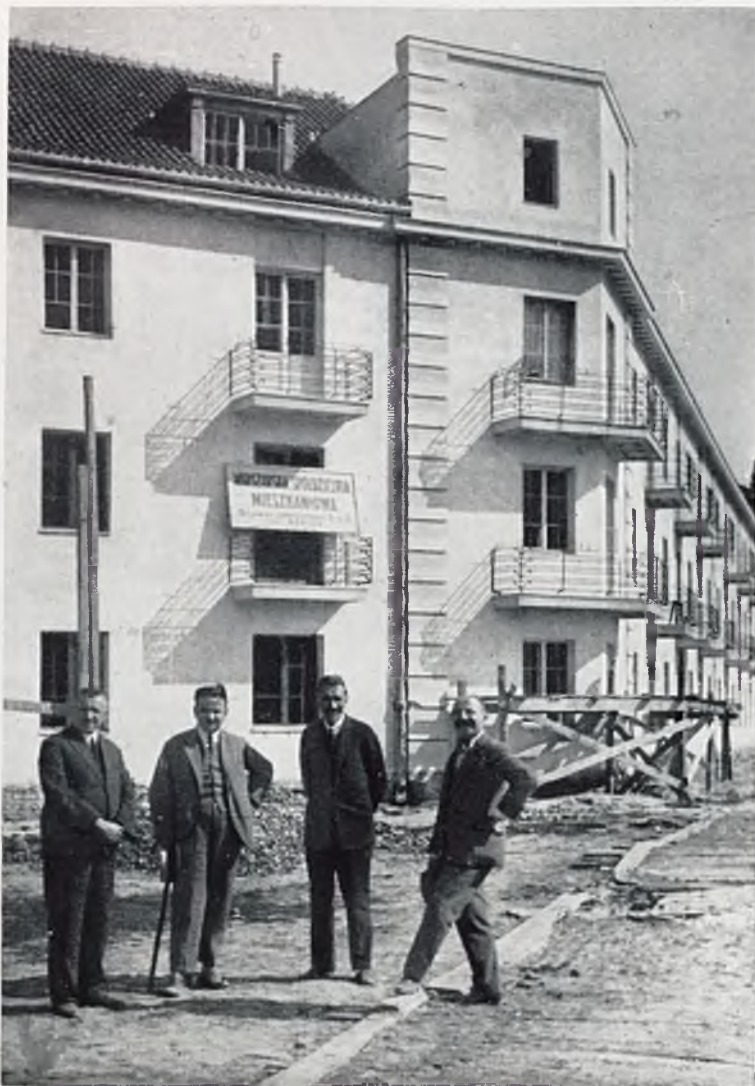
1928. Delegacja Ministerstwa Skarbu na budowie I. Kolonii W. S. M. na Żoliborzu.
