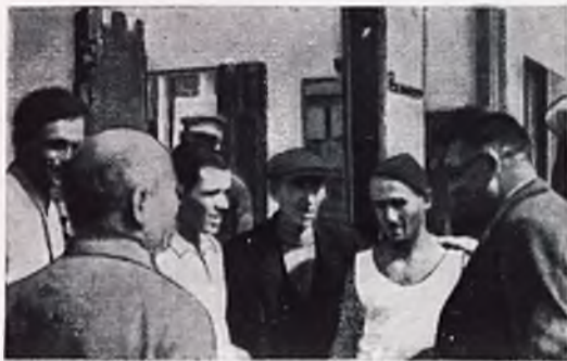
Warszawa, 1936. Ś p. Teodor Toeplitz i i Prezes Międzynarodowego Związku dla Spraw Mieszkaniowych, Minister H. Sellier, (pierwszy z prawej) w rozmowie z robotnikami na budowie osiedla W.S.M. na Rakowcu.
