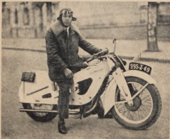
Rys. 15. Motocykl francuski „New Motorcycle“ o ramie z prasowanej blachy stalowej.
