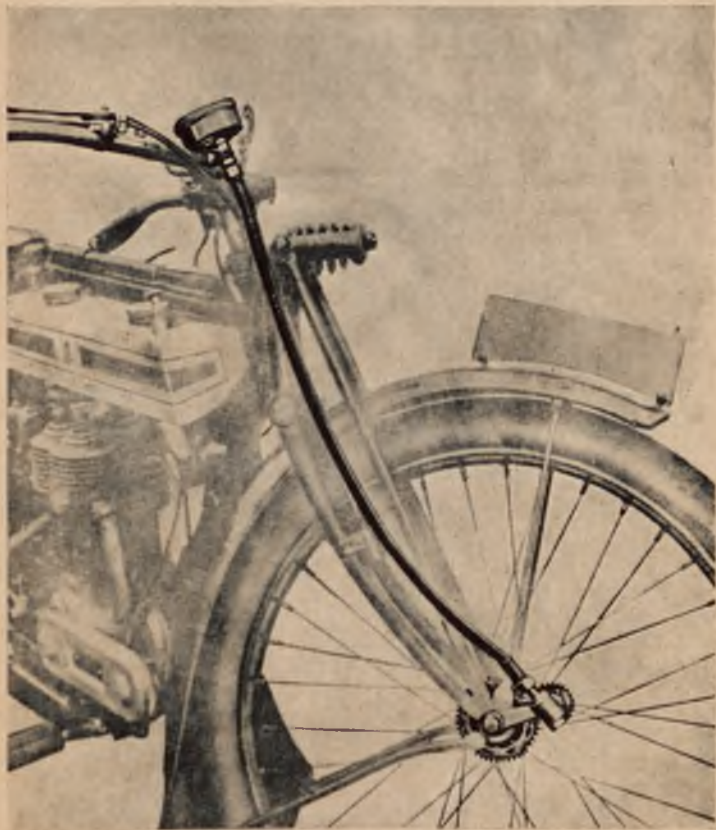
Rys. 182. Kilometromierz i szybkościomierz marki „Bonnixsen“, na kole przednim motocykla. Wystarczy tylko podać markę i typ motocykla, a fabryka posyła gotowy aparat z napędem dostosowanym do danego motocykla.
