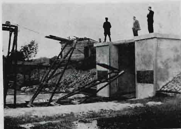
Rys. 4. Wnęka w prawym przyczółku.
