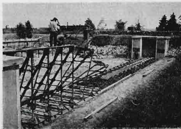
Rys. 10. Składanie konstrukcji ruchomej.
