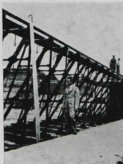
Rys. 6. Widok kozłów od górnej wody.
