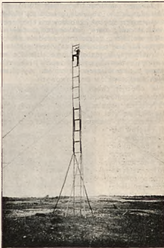
Wywiad triangulacyjny z drabin wiedeńskich, po raz pierwszy do tego celu użytych przez inż. W. Kolanowskiego. Wysokość dwu związanych i odciągniętych linkami drabin wynosi 15 metrów.
