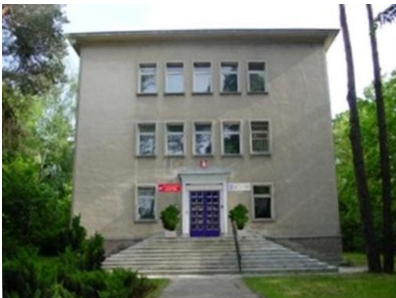
Zakład Techniki Świetlnej
