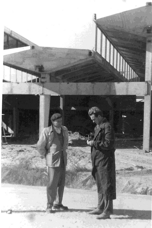
Na terenie budowy fabryki, wiosna 1961 r.
