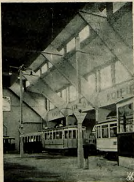
Rys. 5. Słupy stalowo-betonowe Poznańskiej Kolei Elektrycznej.
