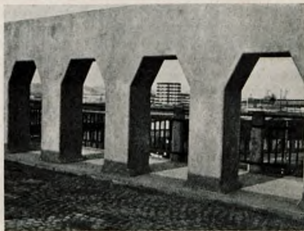
Fragment dźwigara wiaduktu Nr. 1.
