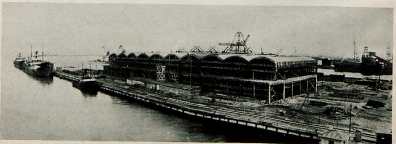
Magazyn tranzytowy w budowie. Il magazzino di tranzito in costruzione. Entrepôt de tranzit en voie de construction. Transit warehouse in construction.
