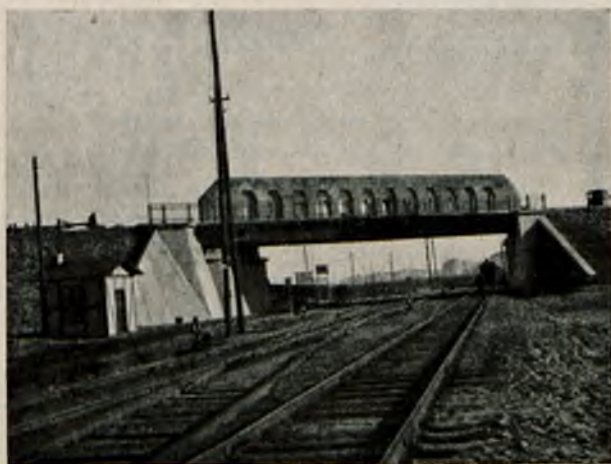
Wiadukt Nr. 1 żelbetowy syst. Vierendeel'a.
