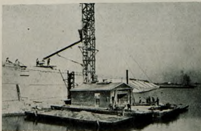
Rys. 8. Betonowanie skrzyń.
