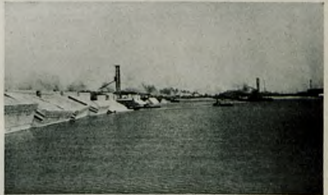
Rys. 9. Ogólny widok placu budowy skrzyń.
