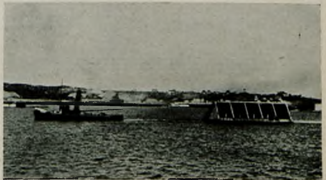
Rys. 10. Holowanie skrzyni. Skrzynia długości 18.40 typu normalnego dla budowy nabrzeży.
