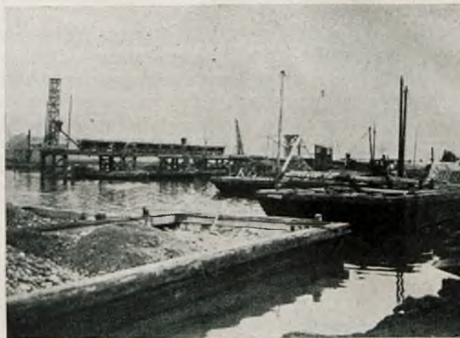
Rys. 4. Pomost przeładunkowy dla materiałów.
