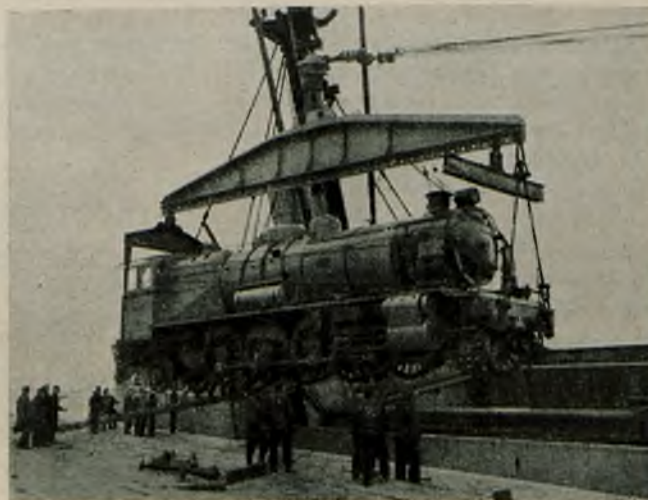
Ładowanie parowozów na okręt. .Caricamento di locomotive a bordo. Embarquement de locomotives dans un navire. Loading of locomotives on the ship.
