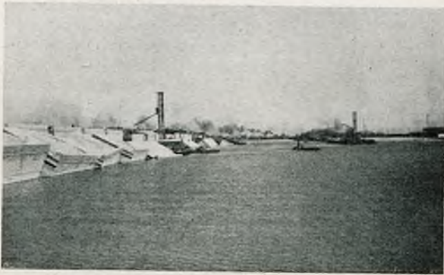
Ogólny widok placu budowy skrzyń. Vista generale della piazza di costruzione delle casse. Vue générale de la place de construction de caisses. General view of the box building yard.
