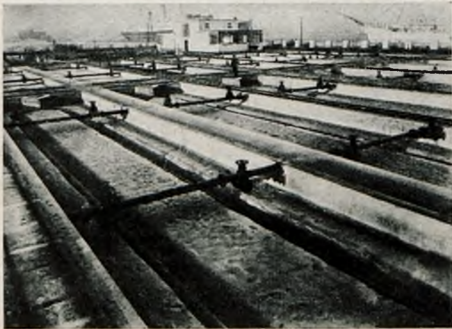
Stacja oczyszczania ścieków.
