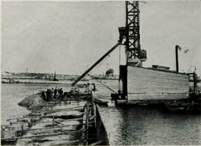
Rys. 6. Betonowanie rusztu i nadwodnych ścian nabrzeży na palach.
