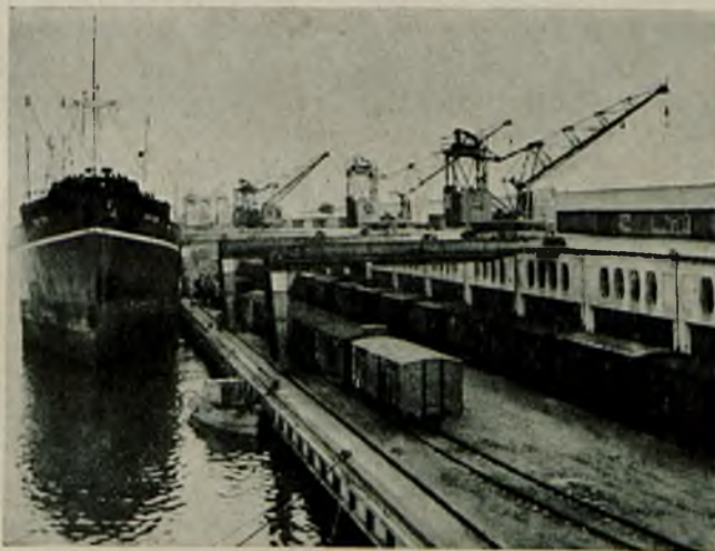
Magazyn bawełniany. Widok od strony basenu (nabrzeża) z kranami półportałowymi.
