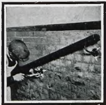
Rys. 1. Mocowanie poręczy metodą Rawlplugs.
