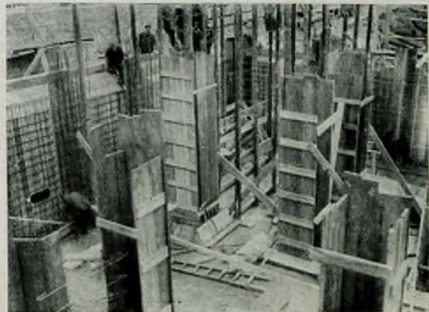
Rys. 3. Deskowanie słupów dolnych wieży.
