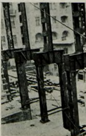
Rys. 12. Frontowe słupy środkowe w najniższych kondygnacjach.
