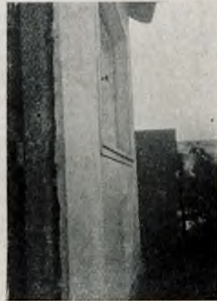
Rys. 3. Przekrój ściany z betonu szlakowego.
