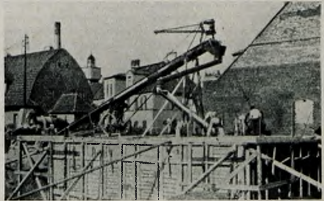
Rys. 5. Wypełnienie deskowań płynnym dimabetonem.
