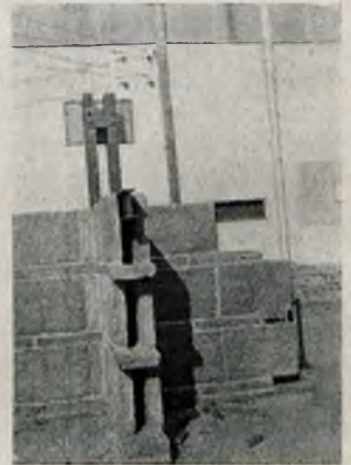
Rys. 4. Szczegół konstrukcji. Wiązanie ścian z bloków gazobetonowych.
