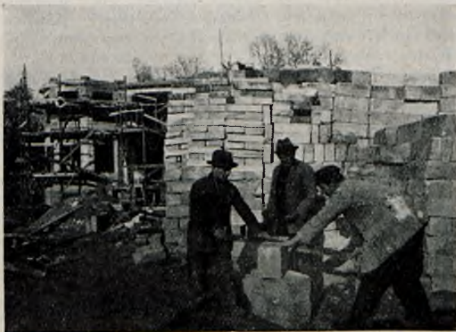
Rys. 2. Budowa domu z bloków gazobetonowych. Obróbka bloków narzędziami ciesielskimi.
