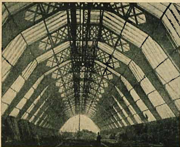
Skład soli potasowej w Olomuńcu, konstrukcja ramowa 22 m. rozpięt. 150 m. dług.
