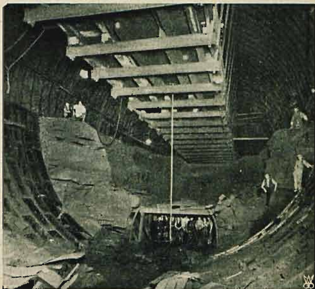
Roboty w tunelu pod rzeką Mersey.
