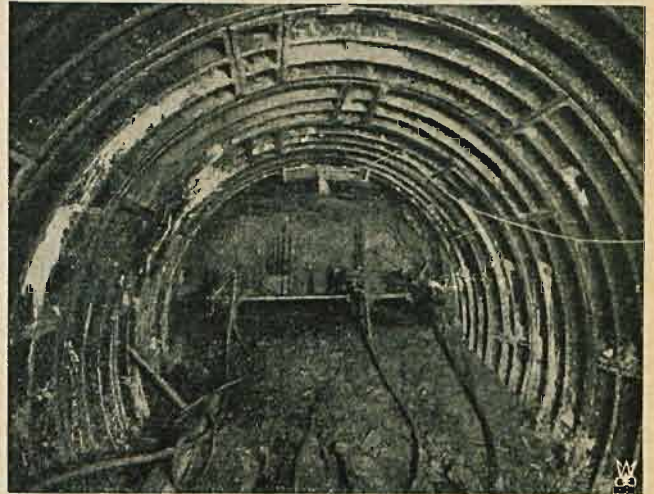
Roboty w tunelu pod rzeką Mersey.
