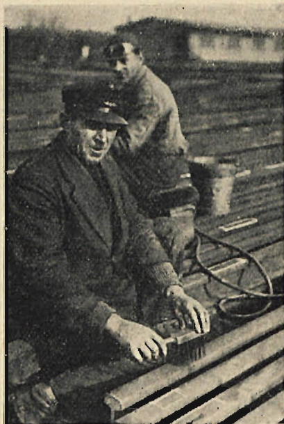
Rys. 12. Czyszczenie szyny drucianą szczotką. Na szynach widać ryski i szczyrbki w obwódkach z kredy.
