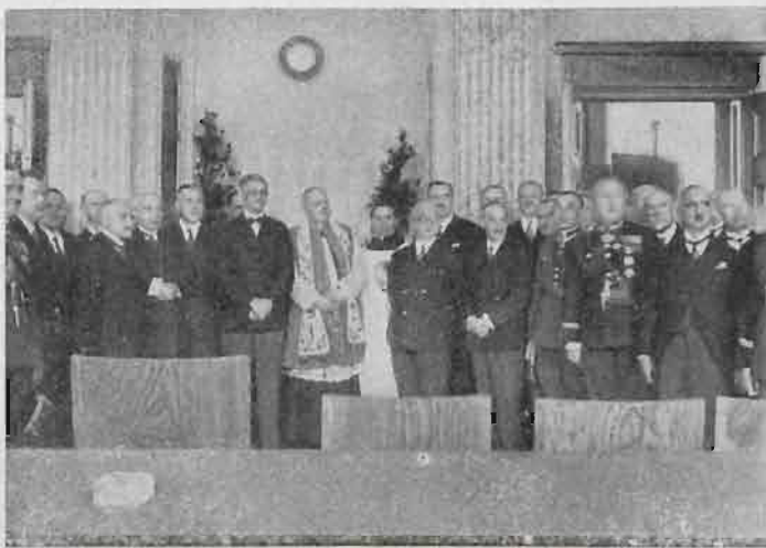
Poświęcenie gmachu Dyrekcji Kolejowej
