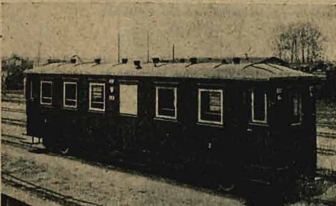
Wagon osobowy dla toru 750 mm., wykonany w warsztatach własnych w Sompólnie. Voiture pour la voie de 750 mm., construite par les ateliers propres à Sompólno.
