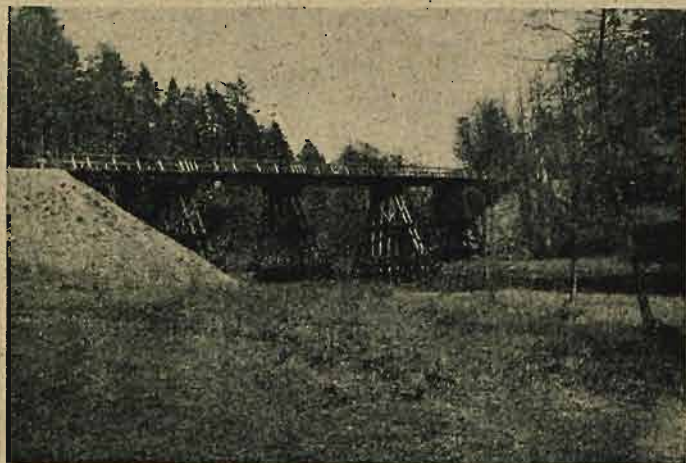
Most na kol. Nowo-Święciany — Kobylniki. Pont sur la ligne Nowo-Święciany — Kobylniki.
