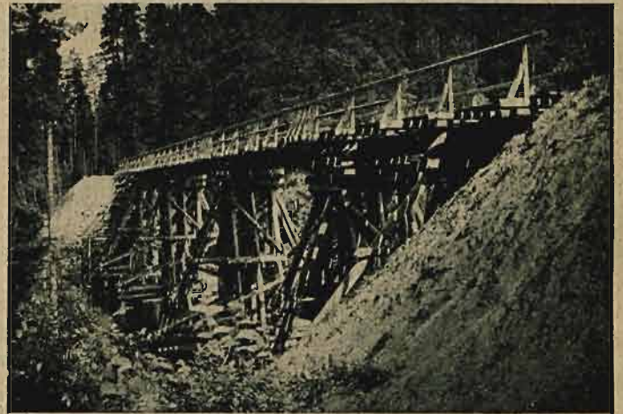
Most na Kolei Nowo-Swięciany-Kobylniki. Pont sur la ligne Nowo-Swienciany-Kobylniki.
