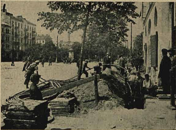
Układanie kabli
