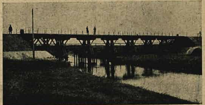
Most na kol. Bialskiej — Podlaskiej. Pont sur le ch. de f. Biala — Podlaska.
