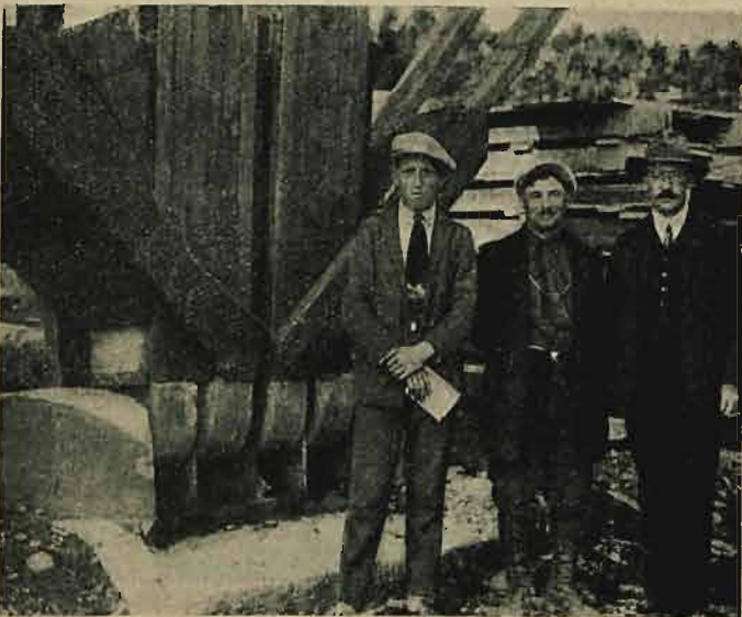
Rys. 26. Podstawa wieżyc kablowych.
