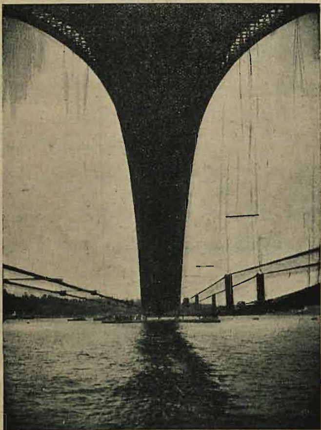
Rys. 43. Widok łuku krążynowego od spodu.
