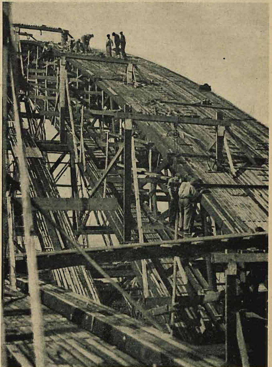
Rys. 39. Budowa krążyn.
