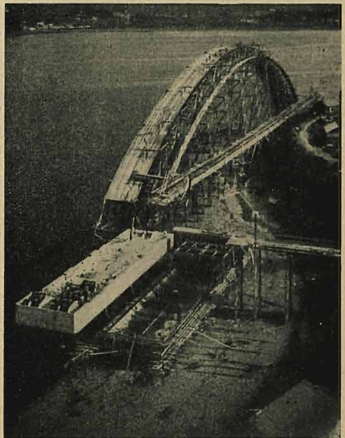
Rys. 40. Budowa krążyn i pontonów.
