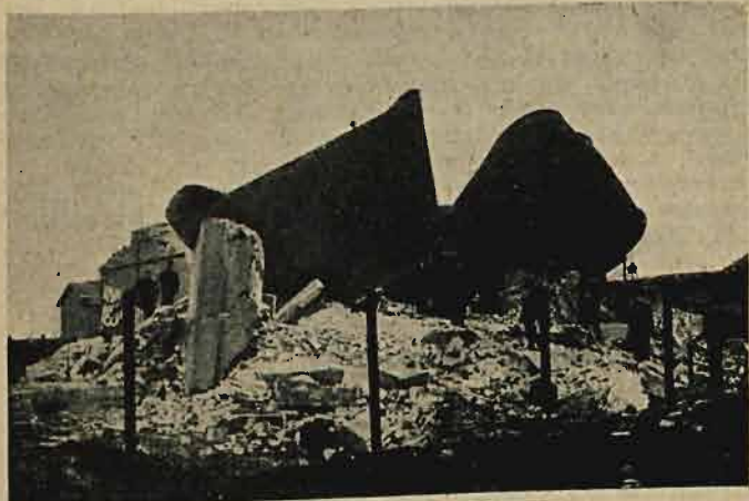
Zburzona wieża cieżni w Piotrkowie.
