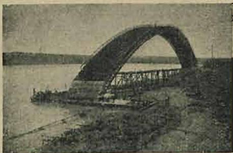
Rys. 41. Krążyny na pontonach gotowe do przesunięcia.
