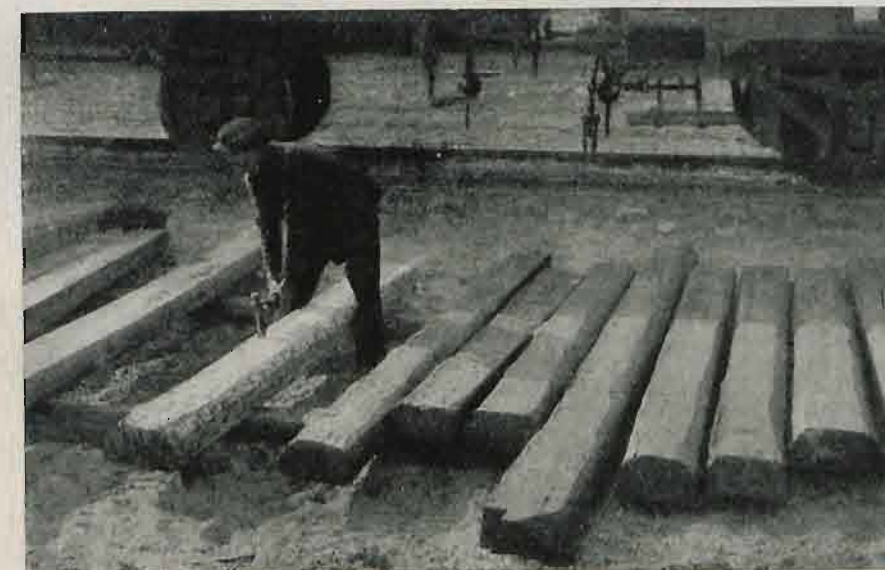
Impregnacja podkładów kolejowych.
