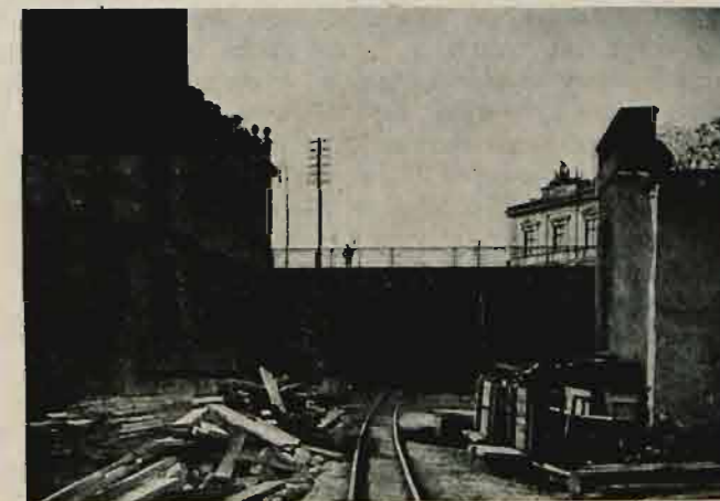
Tunel linii średnicowej. Wylot od strony Powiśla.
