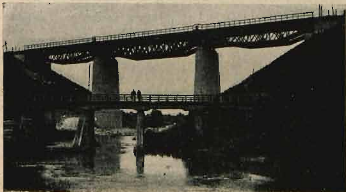
Most przez rzekę Wakę na km 400,3 linii Łapy—Turmont. Widok mostu odbudowanego na stałe; dług. 93,7 m.
