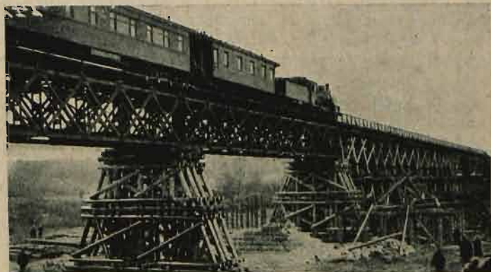
Most przez rz. Horyń na linii Sarny—Równe, odbudowany prowizorycznie przez Dyrekcję K. P. w Radomiu.
