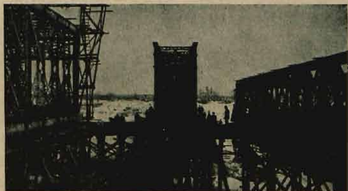
Most przez rzekę Słucz na km 147 linii Kowel—Sarny—Ostki. Nasuwanie zmontowanej części kratownicy, po usunięciu żelaznego dźwigara prowizorycznego systemu Kohna.
