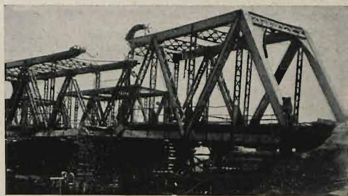
Most przez rzekę Turję; na km 231 linii Dęblin — Kowel — Mohylany i na km. 1 linii Kowel — Włodzimierz. Widok mostów zniszczonych.
