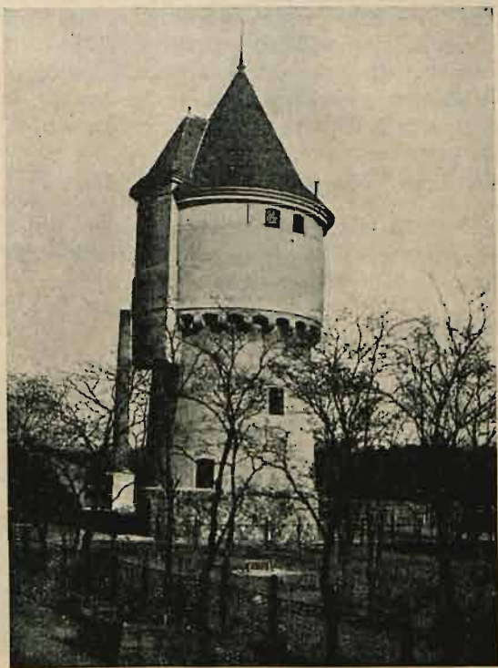
Wieża ciśnień w Skierniewicach.
