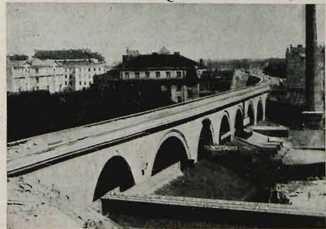
Wiadukt linii średnicowej na Powiślu. Widok ogólny.
