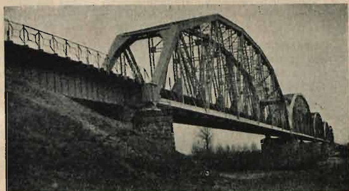
Most przez rz. Prypeć na linii Łuniniec — Sarny. Widok mostu odbudowanego przez pogotowie mostowe Dyrekcji. K. P. w Wilnie. Rozp. w św. 2 \times 83 , 9 + 3 \times 84 , 7 + 2 \times 12,6 m.
