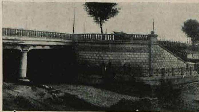
Wiadukt nad ul. Bychowską w Lublinie.
