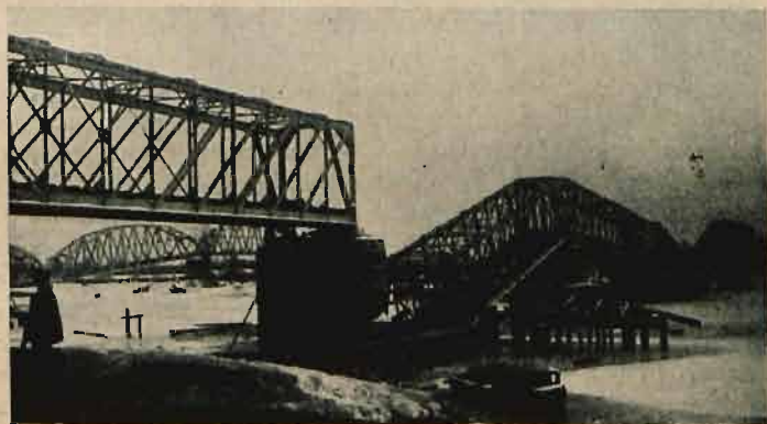
Stary most przez rz. Prypeć na linii Łuniniec — Sarny. Rozp. w św. 4 \times 53,34 + 1 \times 62,94 m. Widok mostu zburzonego, — w tyle widać zburzony most nowy przez rz. Prypeć.
