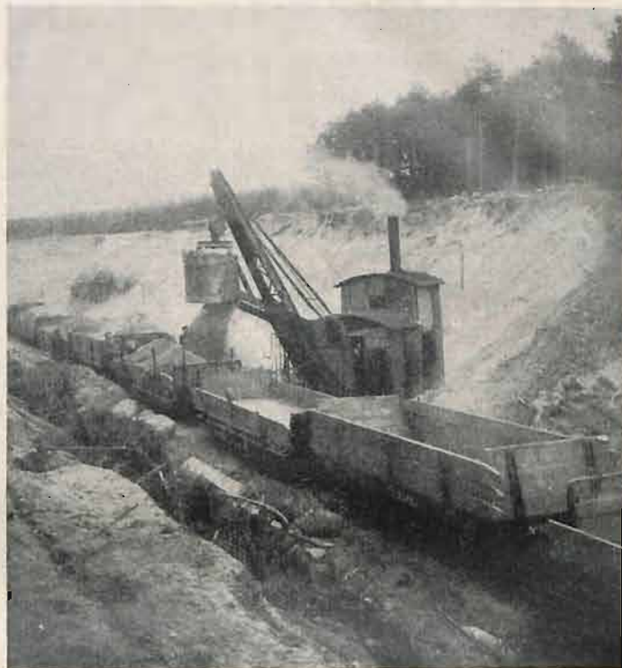
Wykonanie masowych robót ziemnych czerpakiem parowym na południowym obojściu Bydgoszczy.
