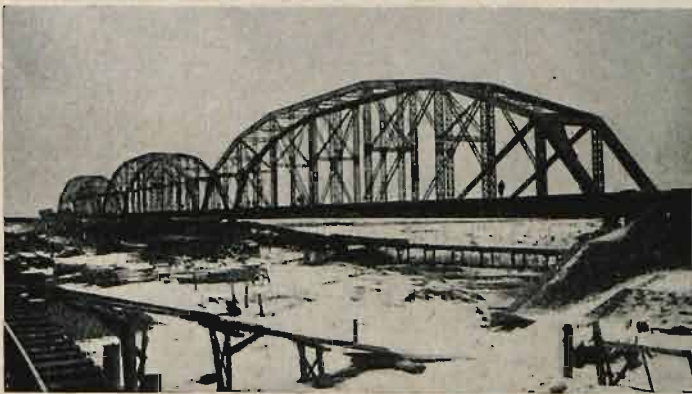
Most przez rzekę San pod Rozwadówem na km 102 linii Lu- blin — Rozwadów. Widok mostu przebudowanego na stały, rozp. w świetle 3 \times 98 m.
