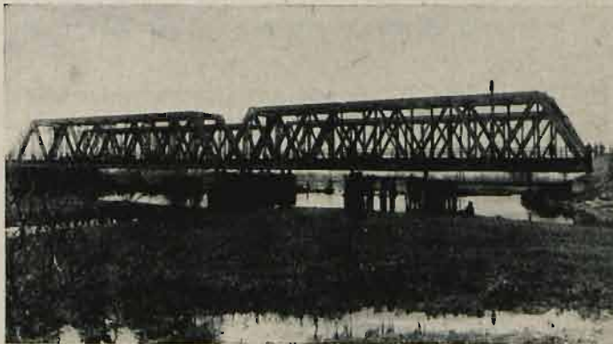
Mosty przez rzekę Turję na km 231 linii Dęblin — Kowel — Mohylany i na km 1 linii Kowel — Włodzimierz. Widok mostów odbudowanych, rozp. w świetle 2 \times 42,7 m.
