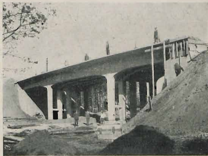
Wiadukt szosowy nad koleją Kalety-Podzamcze.
