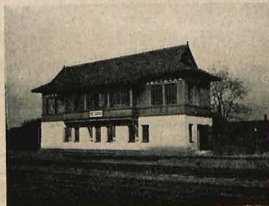
Budka centralizacyjna w Zabkowicach.
