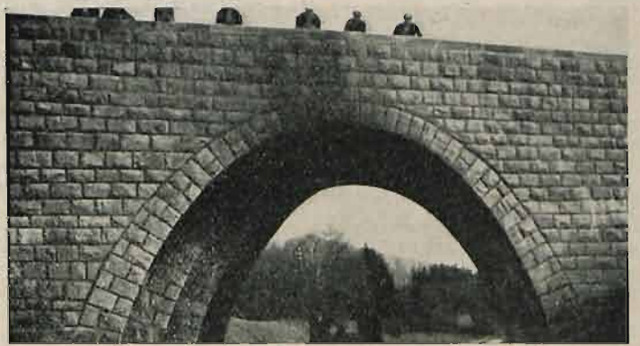
Wiadukt skośny koło Tatarowa na linii Stanisławów — Woronienka.
