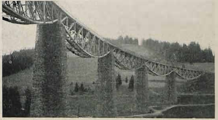
Wiadukt nad doliną rzeki Oporzec na linii Stryj — Beskid; rozp. w świetle 6 \times 40 m.
