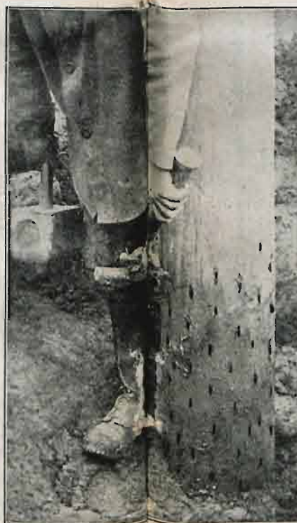
Impregnacja słupów już ustawionych.
