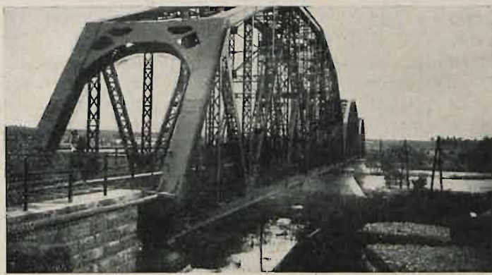
Most przez rzekę Styr pod Czartoryskiem na km 87 linii Kowel — Sarny. Widok mostu odbudowanego na stałe. Rozp. w świetle 3 \times 85,34 m.
