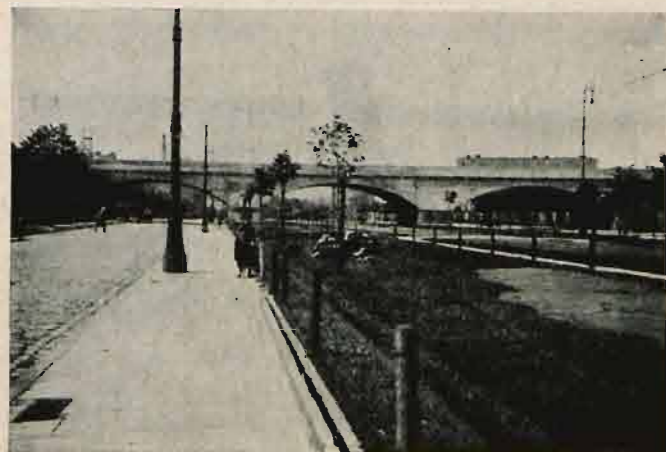
Wiadukt linii średnicowej nad ul. Targową.
