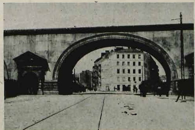
Wiadukt linii średnicowej na Powiślu. Przejście nad ul. Solec.
