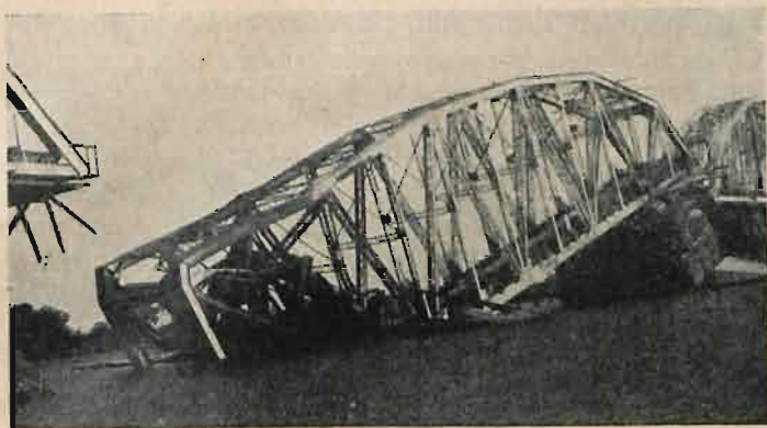
Most przez rz. Prypeć na linii Łuniniec — Sarny zburzony przez wysadzenie filarów.
