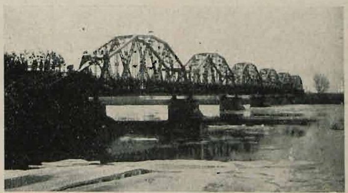
Most przez Wisłę pod Sandomierzem na km. 93 linii Skarzy- sko — Sandomierz — Sobów. Widok mostu przebudowanego na stały, rozp. teoretyczne 6 \times 75 m.
