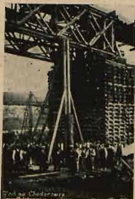
Most przez rzekę Chodorówkę na linii Lwów—Podwołoczyska. Prowizoryczna odbudowa przy użyciu żelaznych dźwigarów systemu Kohna, opartych na kłatkach z podkładów.
