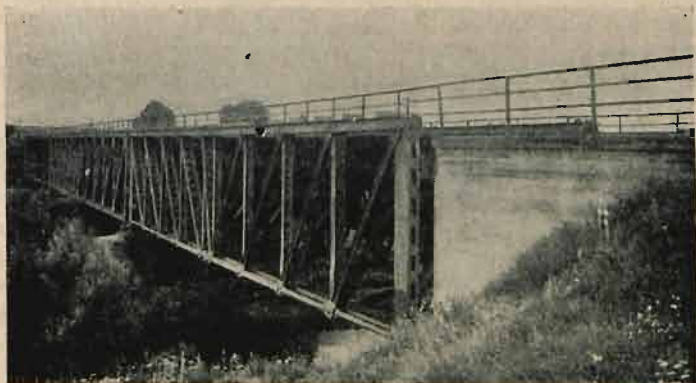
Most przez rzekę Prosnę pod Kaliszem na km 10,9 linii Kalisz—Koluszki. Widok tymczasowych dźwigarów żelaznych systemu Harkorta.
