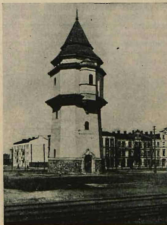
Wieża ciśnień w Żyrardowie po odbudowie.
