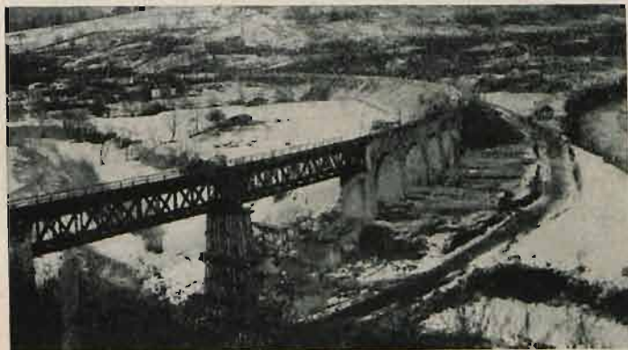
Most przez rzekę Prut w Worochcie na klm. 90\frac{1}{2} linii Stanisławów — Woronienka. Widok mostu, prowizorycznie odbudowanego.
