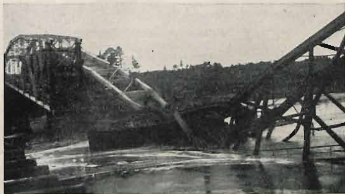
Most przez rzekę Niemen pod Mostami na km. 217,2 linii Siedlce — Zahacie. Widok mostu zniszczonego.
