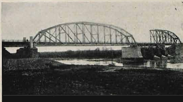
Most przez rzekę Niemen pod Mostami, na km. 217,2 linii Siedlce — Zahacie. Widok mostu prowizorycznie odbudowanego.
