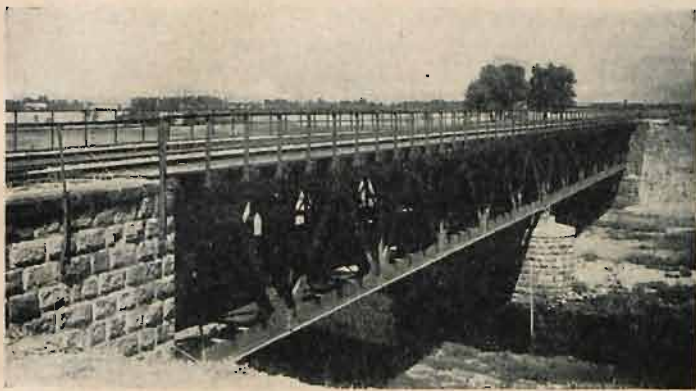
Most przez rzekę Ner na km 109,9 linii Koluszki—Kalisz. Widok mostu odbudowanego, rozp. w świetle 2 \times 31,75 m.
