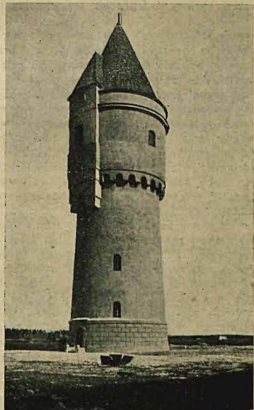
WIEŻA CIŚNIEN NA ST. BARANOWICZE Dyrekcja Kolei P. w Wilnie.
