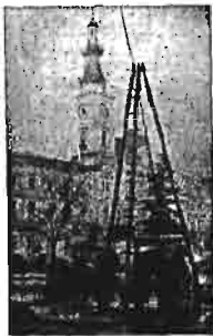
Badania hydro-geologiczne dla budowy „Metro” w Warszawie 1928 r.
