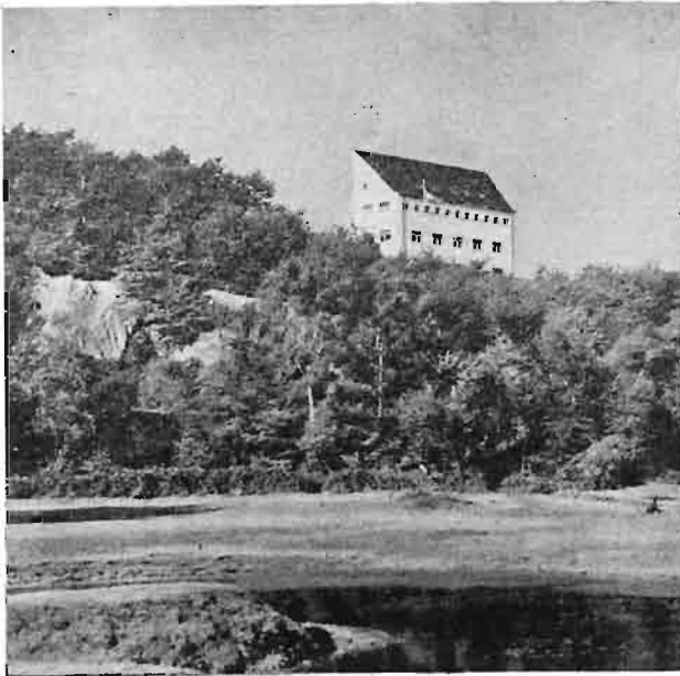
331. Widok na gospodę nad Ruhrą*) arch. E. Hopmann.
