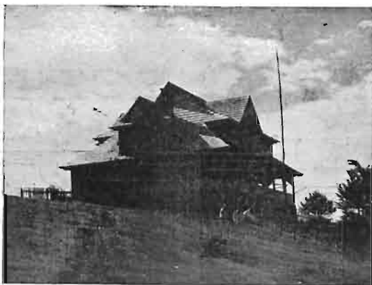
253. Schronisko na Równicy (883 m. p. p. m.) w Beskidach Śląskich.
