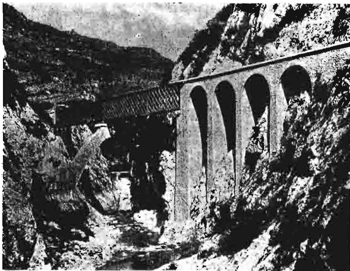
Ryc. 22. Wiadukt Beverà, kolej Nicea-Comi.
